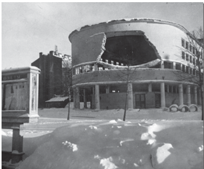
Разрушенное здание школы № 52 Кировского р-на 2
