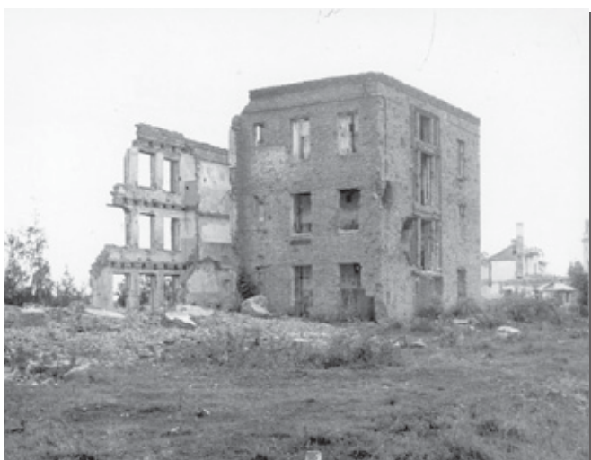
Разрушенное здание школы № 2 Павловска 4
