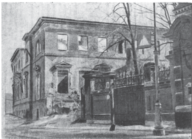
Здание школы глухонемых (наб. реки Мойки, д. 120) разрушено прямым попаданием авиабомбы 3
